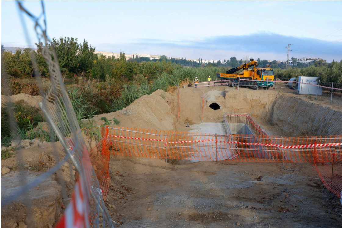
Imágenes de las obras de la segunda fase de la agrupación de vertidos del río Dílar a la Estación Depuradora de Aguas Residuales (EDAR) de Los Vados, en Granada capital Europa Press
